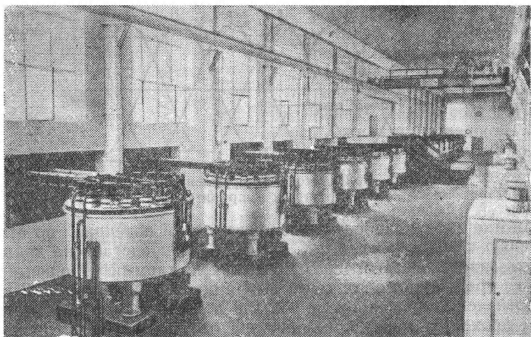
Фиг. 123. Общий вид подстанции с ртутными выпрямителями большой мощности.
